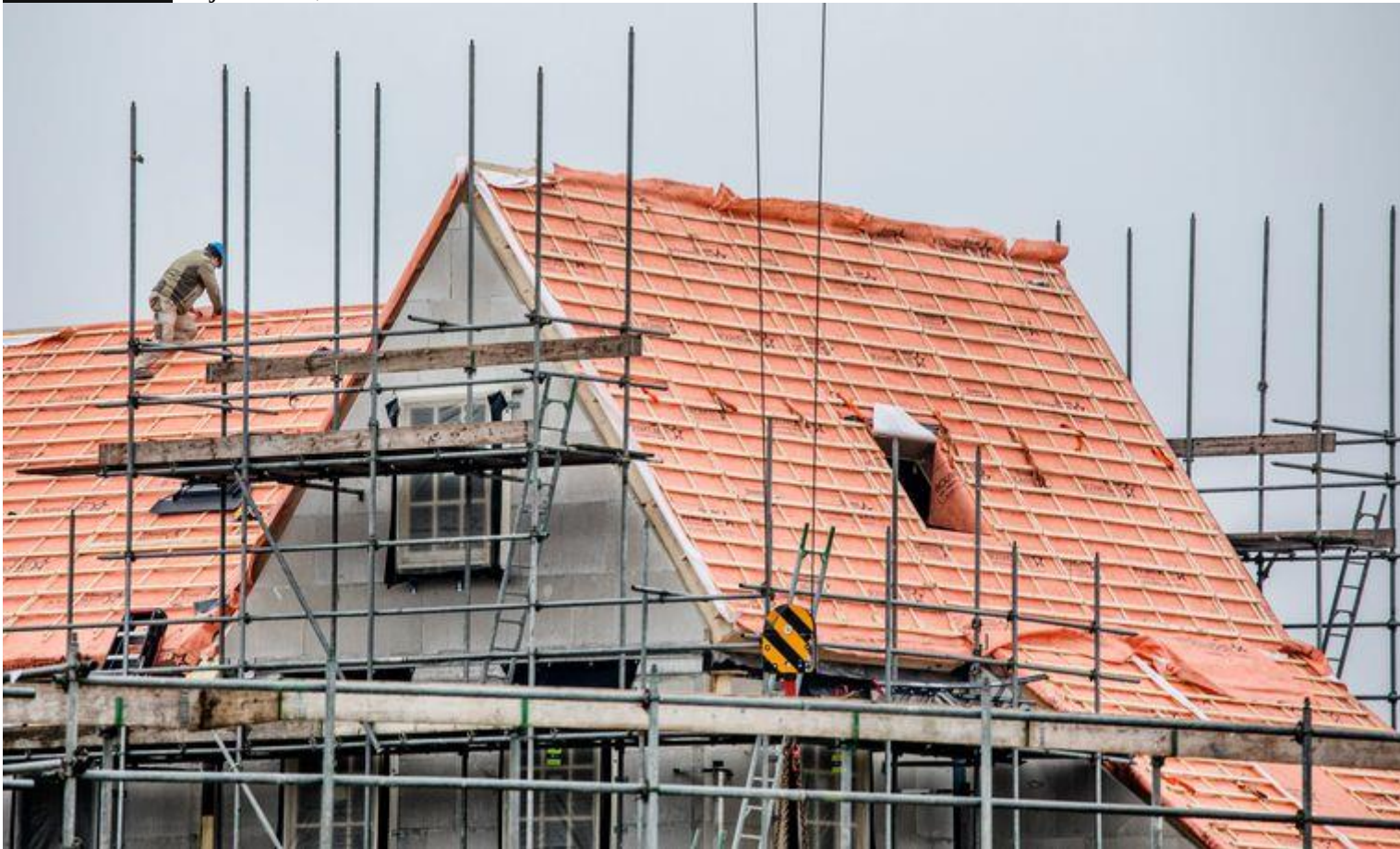
Een woning in aanbouw in Amersfoort. Beeld Raymond Rutting / de Volkskrant
